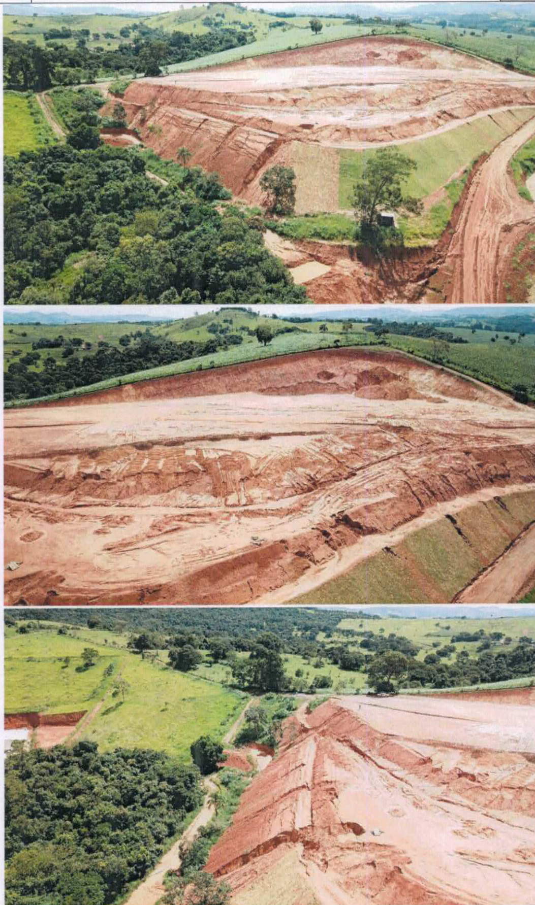
Erosões laminares e profundas que geram o carreamento de terra residuária para dentro da floresta em direção a vale.
