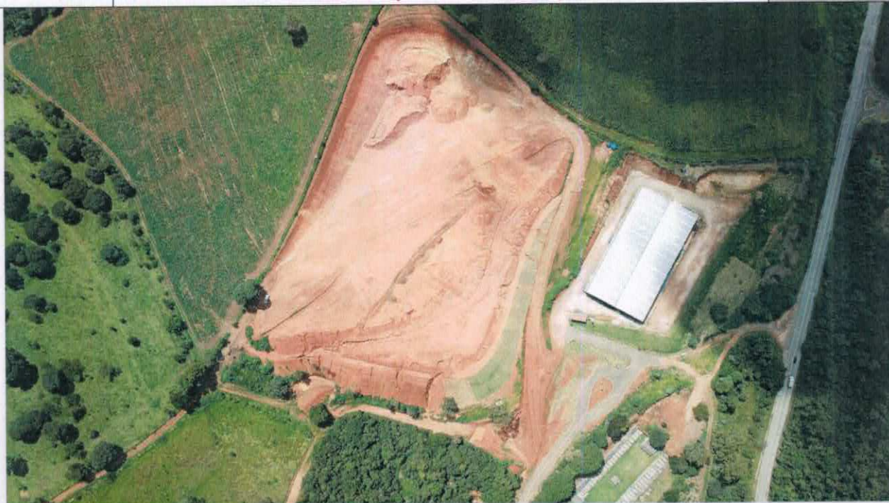
Sinais e erosão profunda nas bordas (taludes) e laminar no platô.
